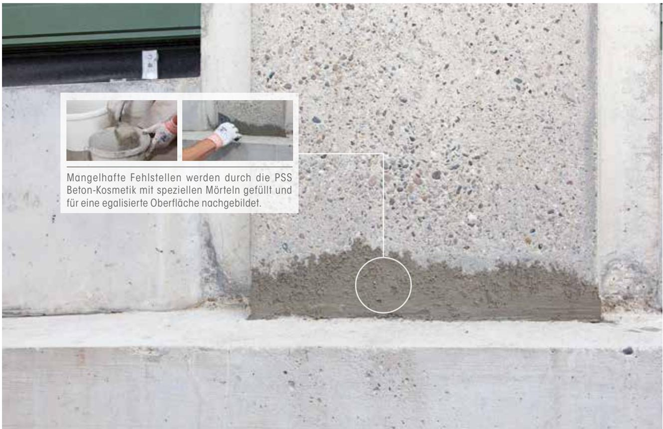
Eine Reprofilierung des Sichtbetons wird in aller Regel dann nachgefragt, wenn substantielle Mängel diagnostiziert werden. Es werden Schadensbilder festgestellt, die häufig auf den ersten Blick irreparabel erscheinen:
